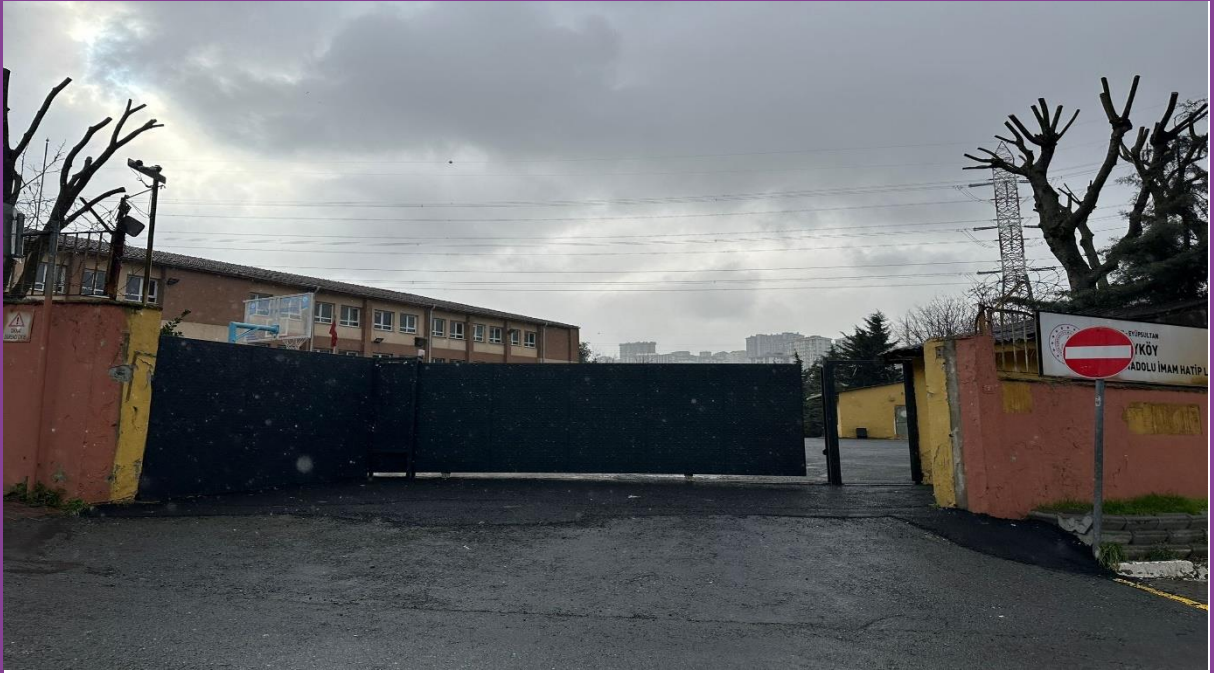
Bina giriş kapısı dışarıdan
