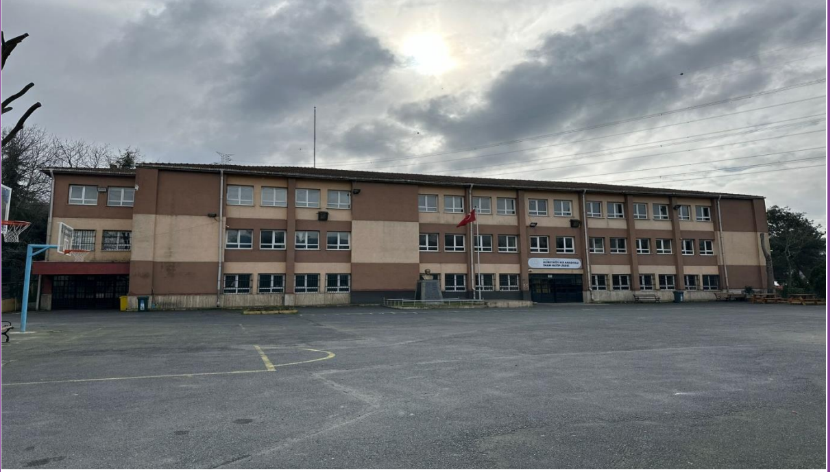
Bahçe kapı girişinden okulun görünümü
